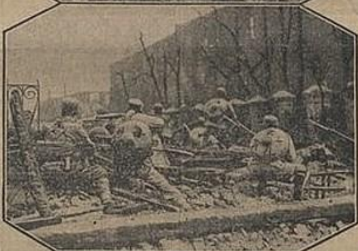
En haut : Une bombe japonaise a causé d'importants dégâts sur une voie de la gare du Nord à Chapeï, dont les bâtiments sont visibles à l'arrière-plan. — En bas : Des soldats chinois, enjambant une barricade, attaquent les Japonais à la baïonnette. Ils portent, attaché dans le dos, le classique chapeau de paille, avec l'inscription : « 19 e armée de marche ».
