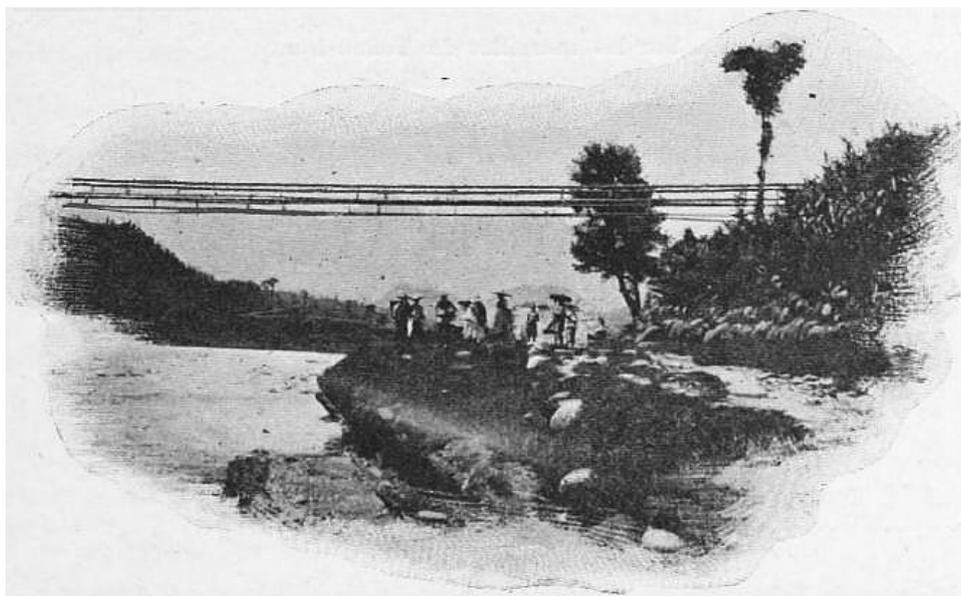
**Conduite d'eau en bambous traversant la rivière de Ya-tcheou fou.**
