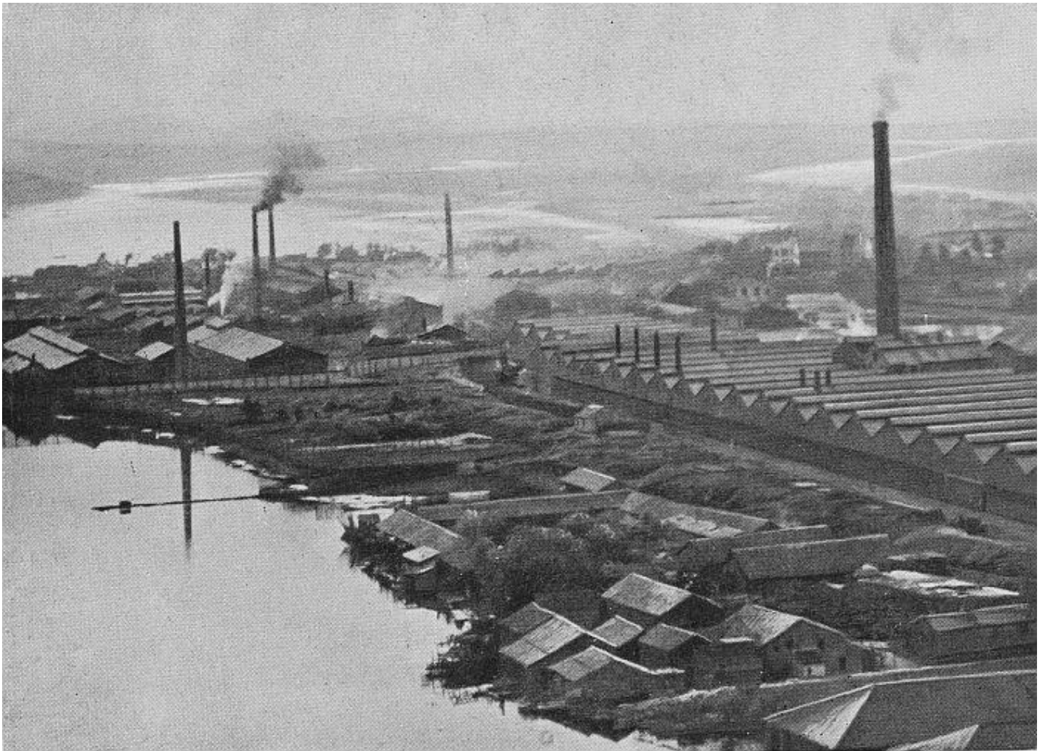
Le progrès moderne à Han-Keou. Forges et hauts-fourneaux.
