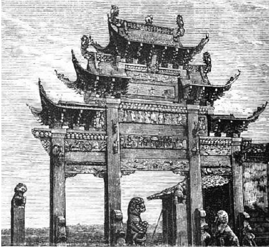
Le portique de l'avenue.
