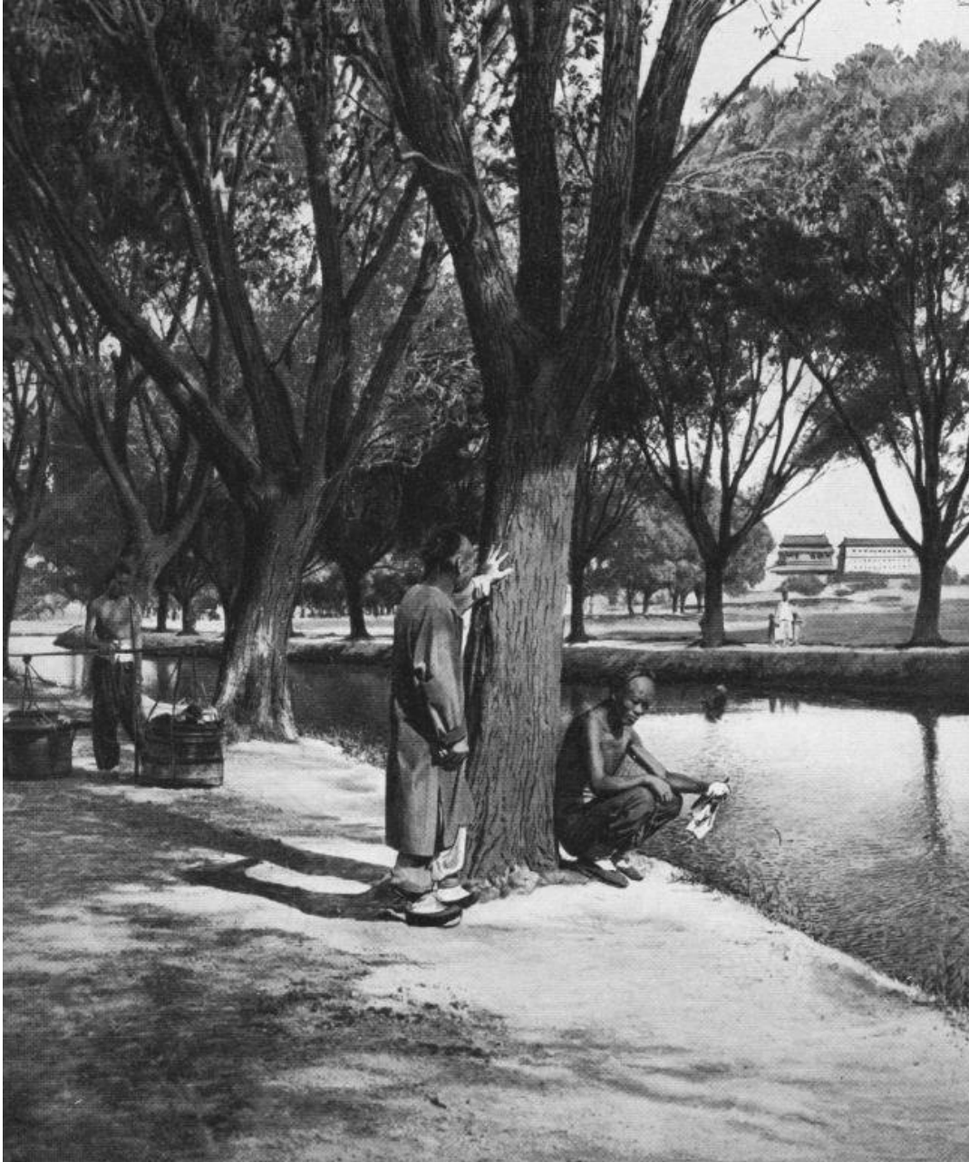
Canal bordé de saules. Grand Canal et porte Occidentale de Pékin.
